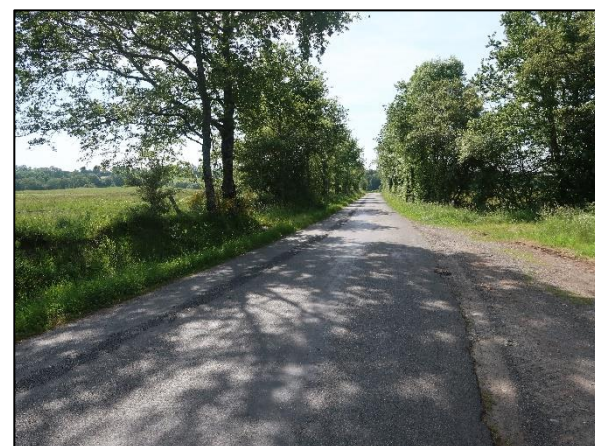
Route départementale D522 sur la ZIP Source : Artifex 2019
